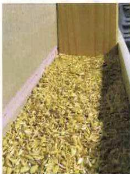
Balle de riz en remplissage de caisson isolant.
