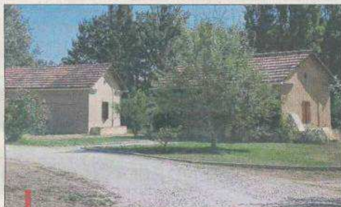
Ces pavillons de briques de terre compressée ont été construits par les résidents du Village.
