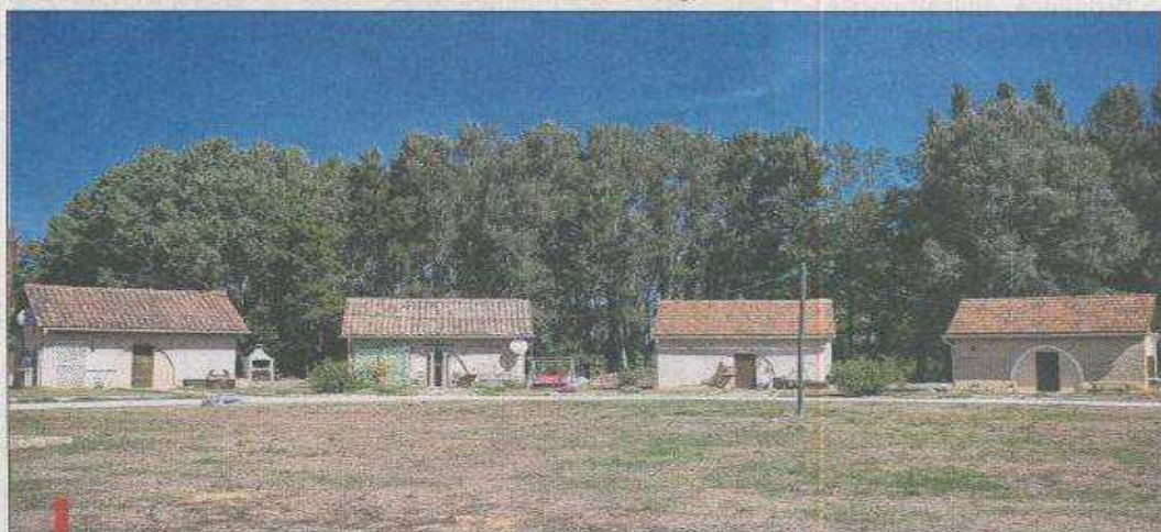
Les résidents du Village construisent eux-mêmes leurs habitations à l'aide de briques de terre compressée confectionnées sur place.
