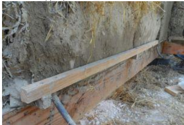
Liteau positionné en bas des murs d'une maison paille CST
