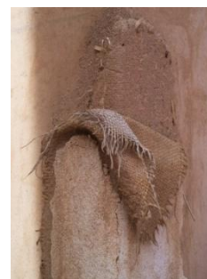
Toile de jute (maillage fin), noyée dans le corps d'enduit, pour renforcer un angle sortant
