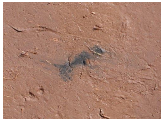
Trace de cendre de palmier dans un enduit terre (Tagounite, Maroc)
