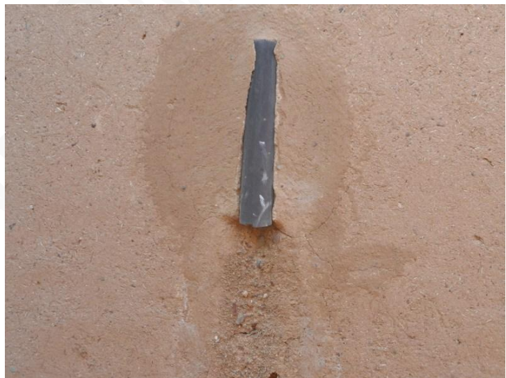
Enduit stabilisé autour et sous une évacuation d'eau « verticale », (Agdes, Maroc)
