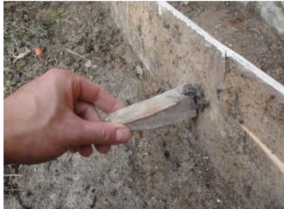
Tenon sur lequel est pointé une plinthe dans une vieille maison en pierre
