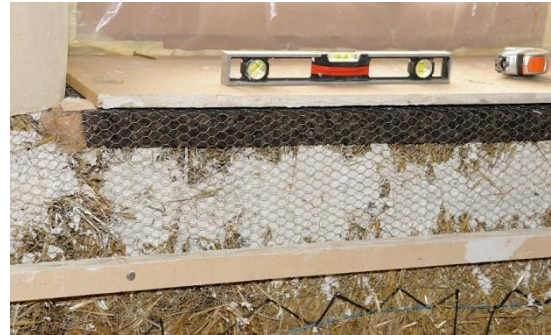
Grillage à poule au bas d'une fenêtre / mur en paille
