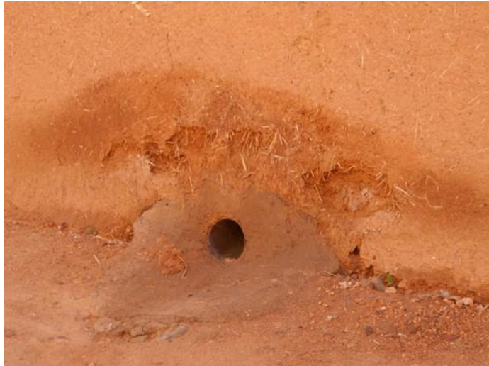
Évacuation d'eau en pied de mur + ciment (Nekob, Maroc)
