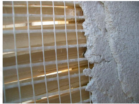
canisse sur ossature bois + trame plastique, pour cloison intérieure
