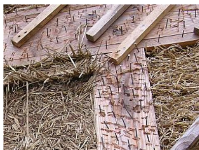
Pointes galva sur ossature bois - Nattes de roseaux
