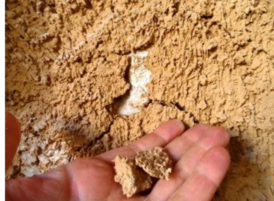
Renformis trop gras sur support pas assez humidifié, projeté partout (y compris en dehors des trous)
