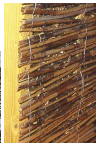
Pointes galva sur ossature bois - Nattes de roseaux
