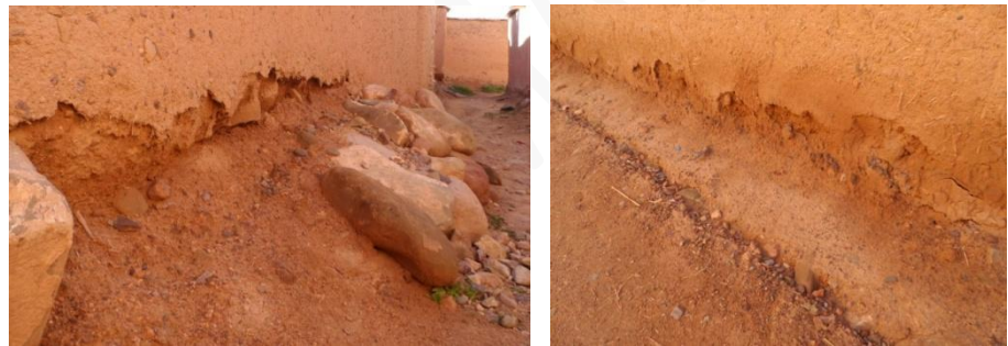
Conséquences à long terme sur un pied de mur (Nekob, Maroc)
