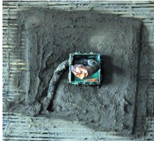
Renforcement à la filasse autour d'une prise électrique
