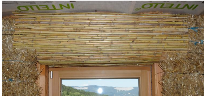
Canisse pour encadrement de fenêtre sur mur en paille
