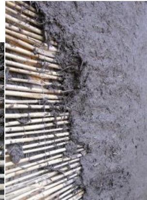
Canisse sur ossature bois contreventée pour mur extérieur
