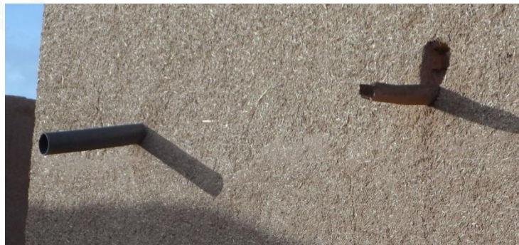
Évacuations modernes en PVC & traditionnelle en palmier (Mhamid, Maroc)
