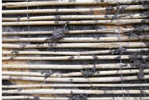
Canisse sur ossature bois contreventée pour mur extérieur
