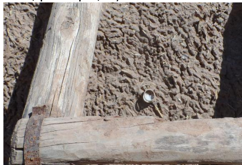
Capsule plastique dans un enduit terre extérieur (Tagounite, Maroc)
