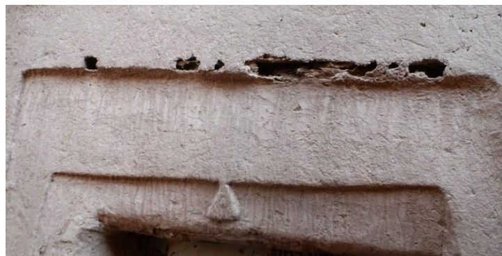
Linteau de porte mangé par les termites (Ouled Driss, Maroc)
