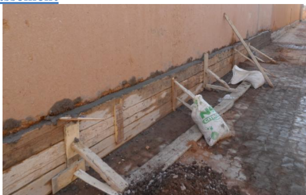
Réalisation d'un enduit de protection en pied de mur (Agdes, Maroc)
