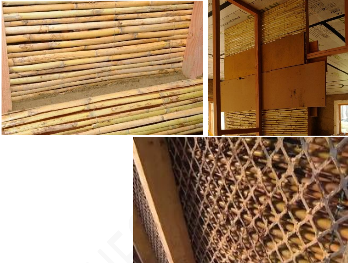
Utilisation de la canisse en coffrage perdu
