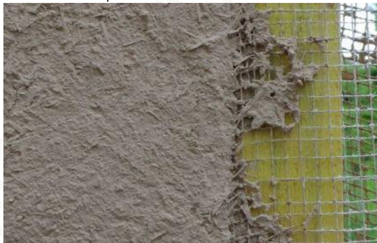
Enduits terre sur treillis métallique souple ( grands ateliers, Villefontaine)
