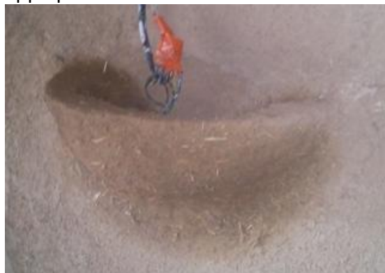
Enduit de corps sur structure en grillage à poule
