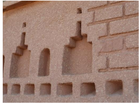
Sgraffito et niches décoratives sur mur en terre (Mhamid, Maroc)
