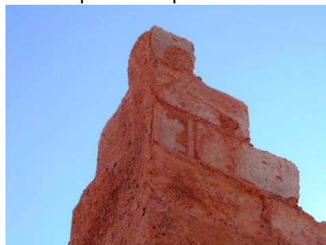
Face érodée par la pluie, face protégée de la pluie (Tagounite, Maroc)
