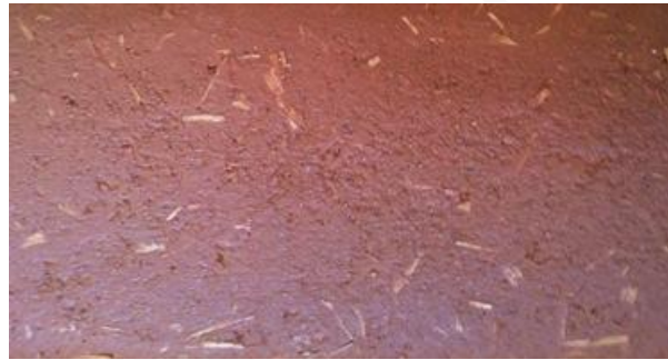
Cadre réalisé avec un enduit terre, badigeonné d'un mélange lait-ocre rouge
