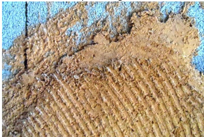
Barbotine puis enduit de corps sur parpaing creux (formation)
