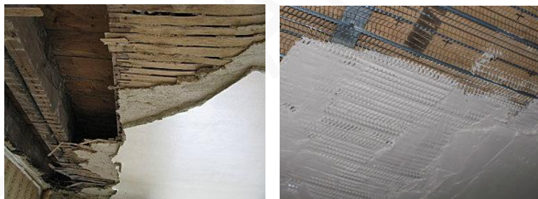
Plafond en plâtre sur lattis et sur Nergalto
