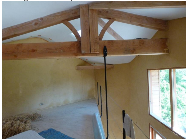
Enduit intérieur sur botte de pailles - Mme S - 2014 - chantier participatif, Drôme provençale
