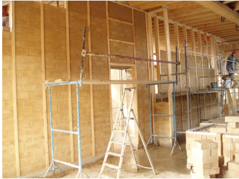
Chantier de l'école des Granges Gontardes - entreprise Provence concept - novembre 2014, Drôme
