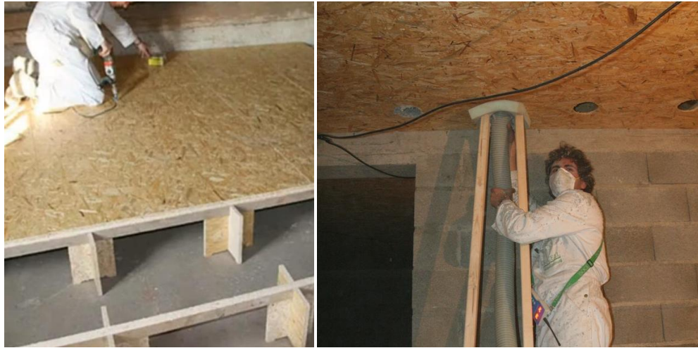
Insufflation d'isolant dans des planchers et des plafonds
