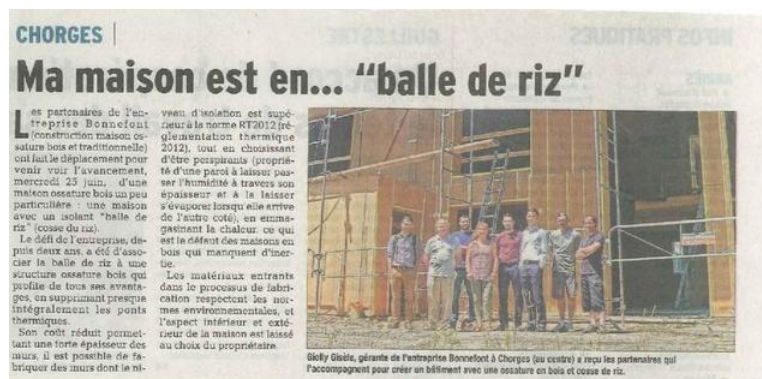
Première maison isolée en balle de riz, préfabriquée en atelier
